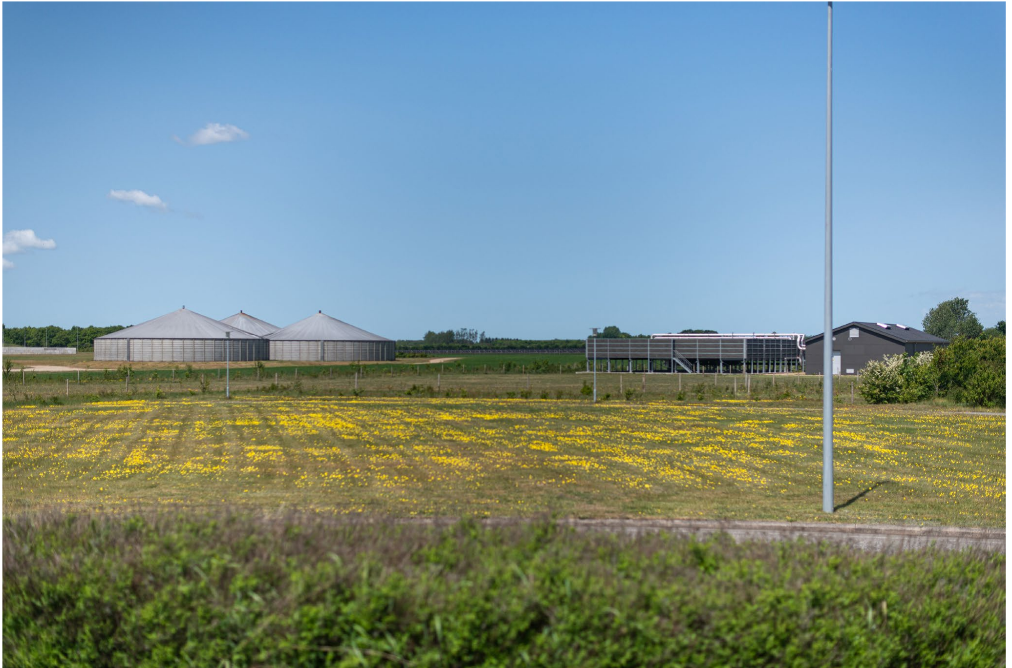
2: Karup sydvest, A12 Herningvej v. rundkørslen
