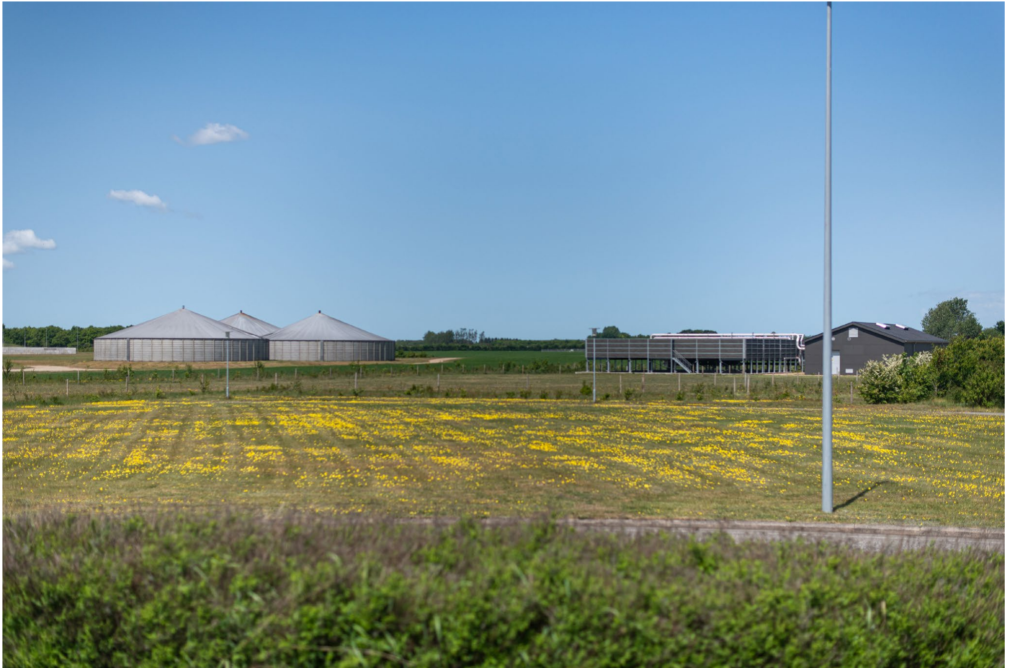
2: Karup sydvest, A12 Herningvej v. rundkørslen
