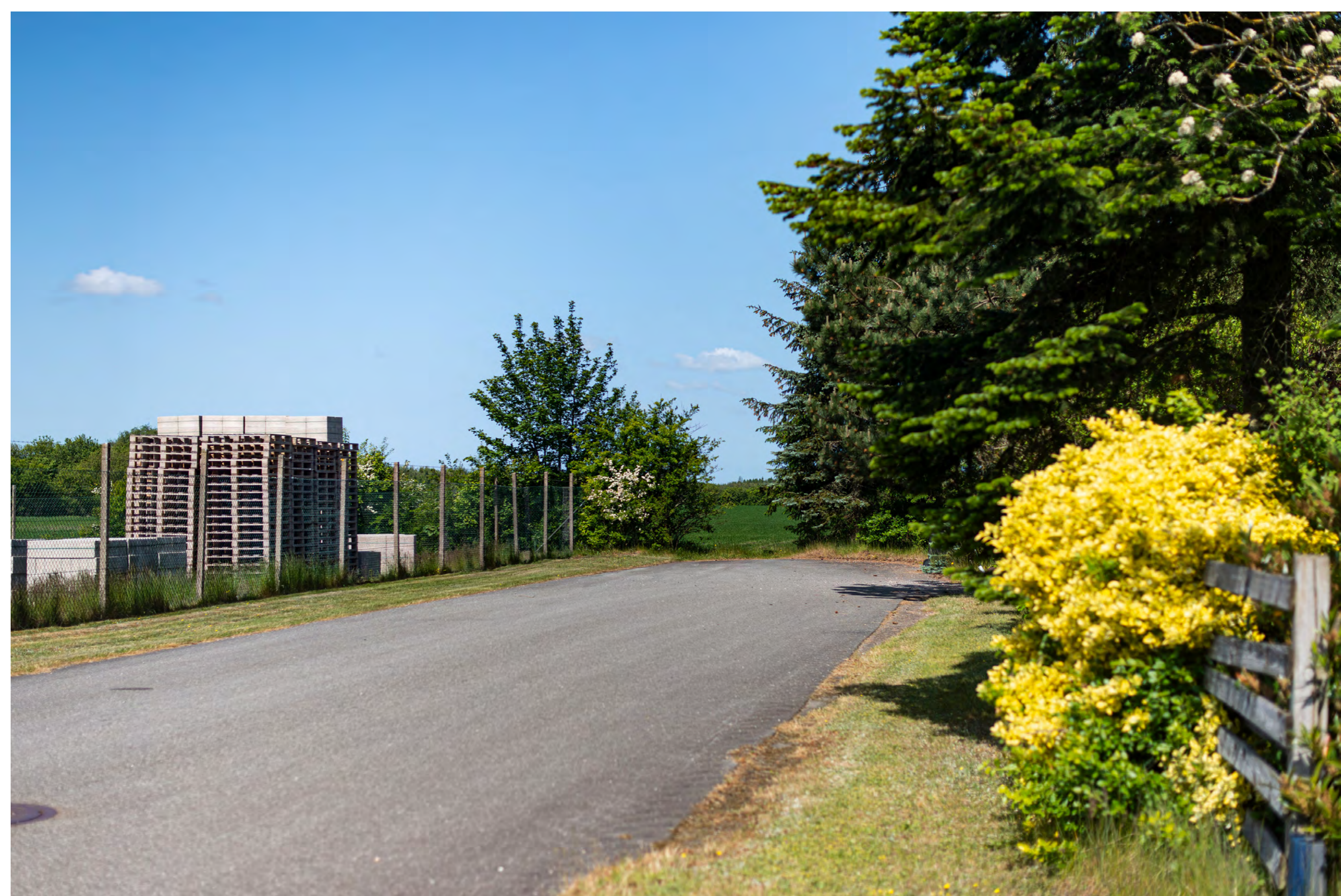
1. Industrivej ved Elementvej
